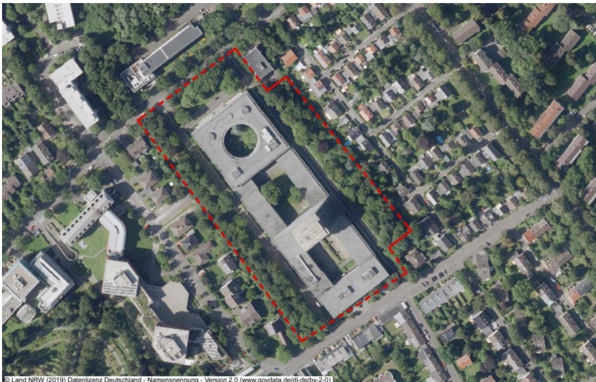
Abb.: Baufeld (Altbestand wird abgerissen)
